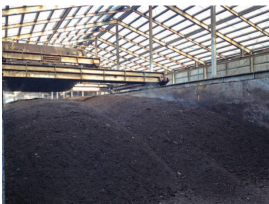
（工場内（一次発酵槽）の様子）
